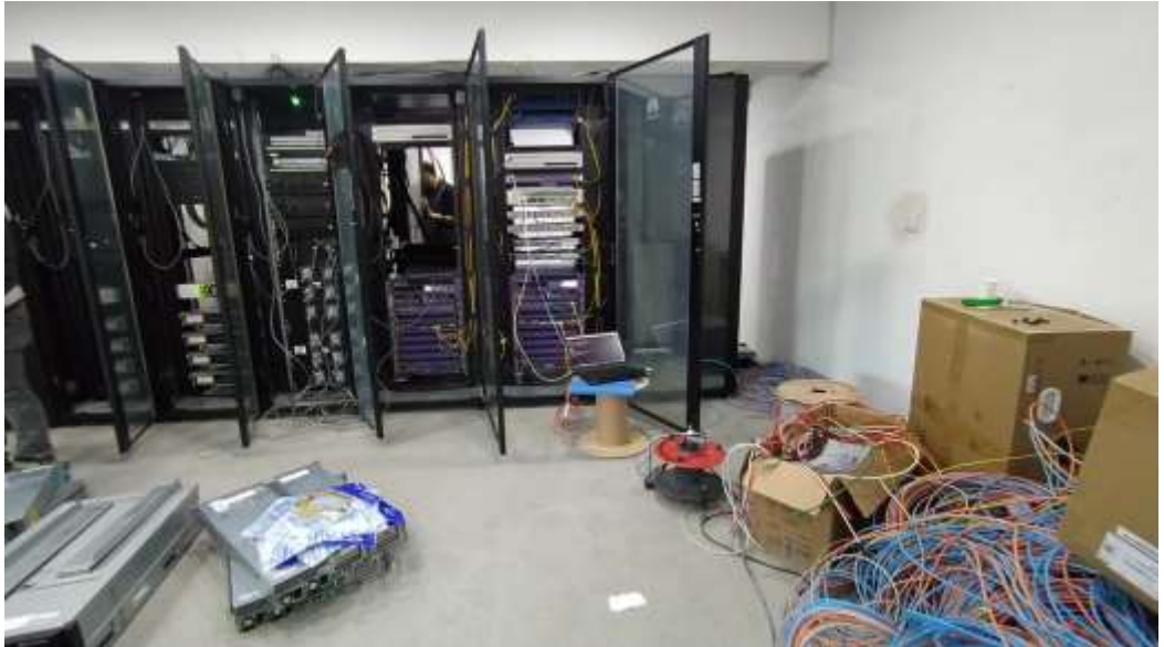
Yapım alıřması devam eden yeni Sistem Odası
